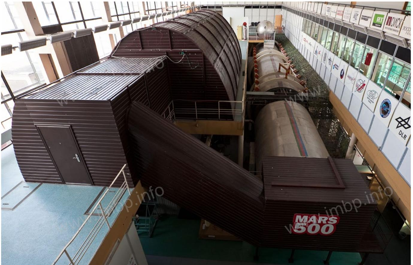
Медико-технический комплекс ГНЦ РФ – ИМБП РАН предназначен для моделирования условий жизни и деятельности экипажа, максимально приближенных к условиям реальных космических объектов, обеспечению проведения эксперимента, моделирующего космический полет, в том числе межпланетный, длительностью
